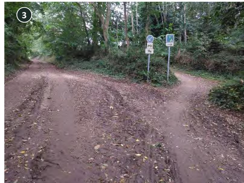
1. Sur les 6 kms environ qui relient Douarnenez à Poullan-sur-Mer, il existe une voie verte sur environ 2,5 km depuis Douarnenez. Celle-ci est accessible aux cavaliers circulant au pas. Dès l'entrée, on observe **que la largeur roulante (inférieure à 2m) n'est pas conforme aux caractéristiques d'une voie verte (3m minimum)**.
