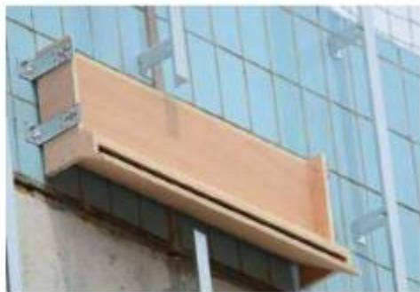
Figure 3 : structure du gîte avant pose de l'isolant
