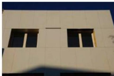
Figure 4 : Visibilité des gîtes après la pose du bardage
